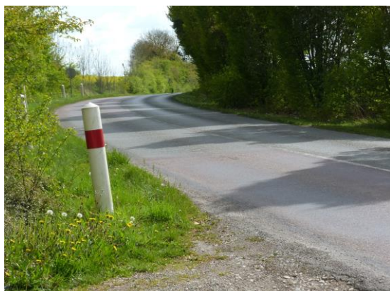
Carrefour au niveau de la RD12
